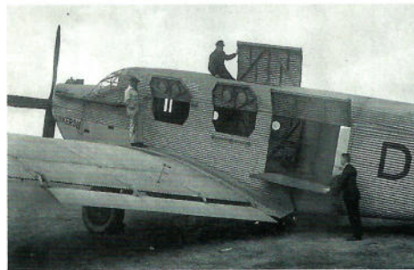
Die großen Frachtluken an der Seite und im Dach ermöglichten ein einfaches Beladen.
