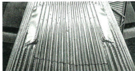
Im Boden konnten Luken für eventuelle Bombenabwürfe integriert werden.
