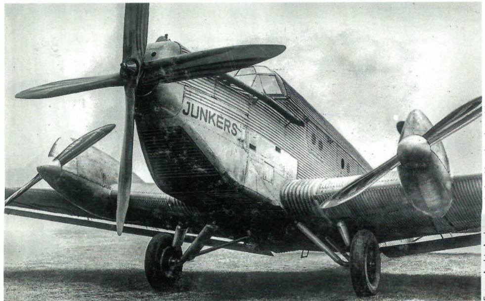
Erstmals mit drei Motoren, davon jedoch zwei Attrappen, versehen wurde diese Junkers für Versuche genutzt. Am Ende war der Einbau zweier weiterer Motoren die Rettung des Modells.
