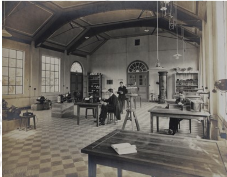
Abb. 4: Elektrotechnisches Labor im Laboratorium Baumweg der Ingenieur-Akademie 1910/1911 (Foto: Archiv der Hansestadt Wismar)
